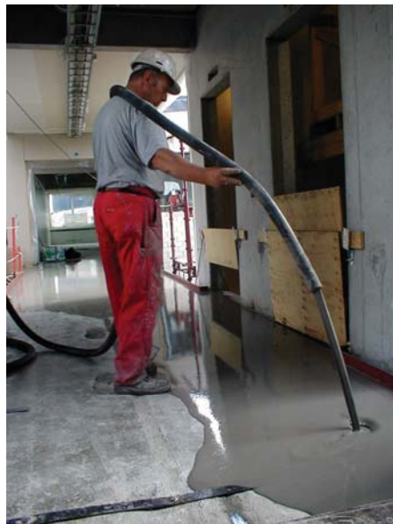
Uitvoering van een zelfverdichtende gietvloer.
