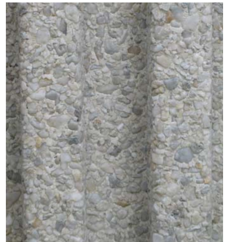
Afb. 2 Lichter geveloppervlak : de donkere granulaten zijn overdekt met witte zouten.
