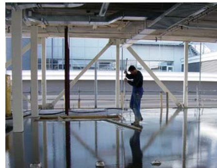
Ontluchten en nivelleren van de gietvloer.
