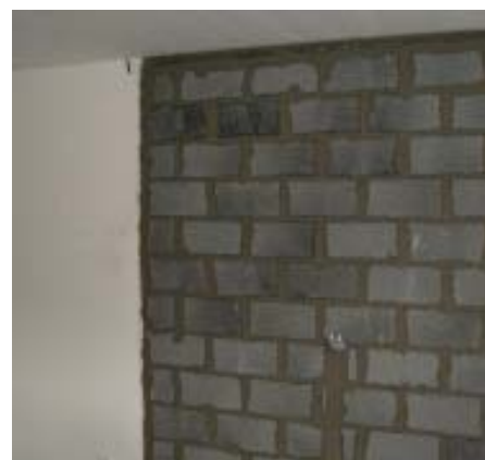
Afb. 1 De bepleistering (afwerking) heeft een min of meer belangrijke invloed op de akoestische isolatie van muren uit metselwerk.
