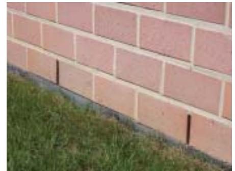
Afb. 3 Stootvoegen, geopend tot op het onderliggende membraan (dat idealiter uit de muur zou moeten uitsteken).
