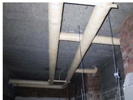
Afb. 2 Warmte-isolatie van leidingen.
