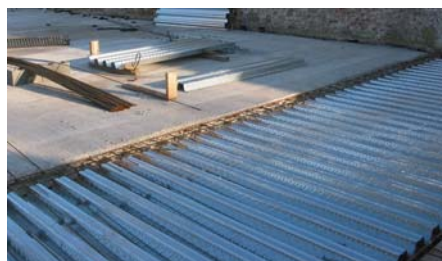
Staalplaat-betonvloer tijdens de uitvoeringsfase.
