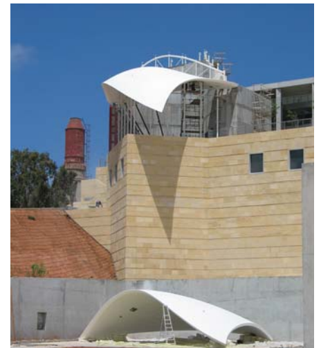
Herdenkingsmonument voor Yitzak Rabin, met een dakconstructie uit glasvezelversterkt polyester en EPS.
