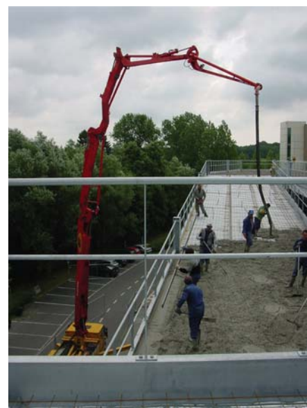
Storten van beton op een koudvervormde geprofileerde staalplaat.
